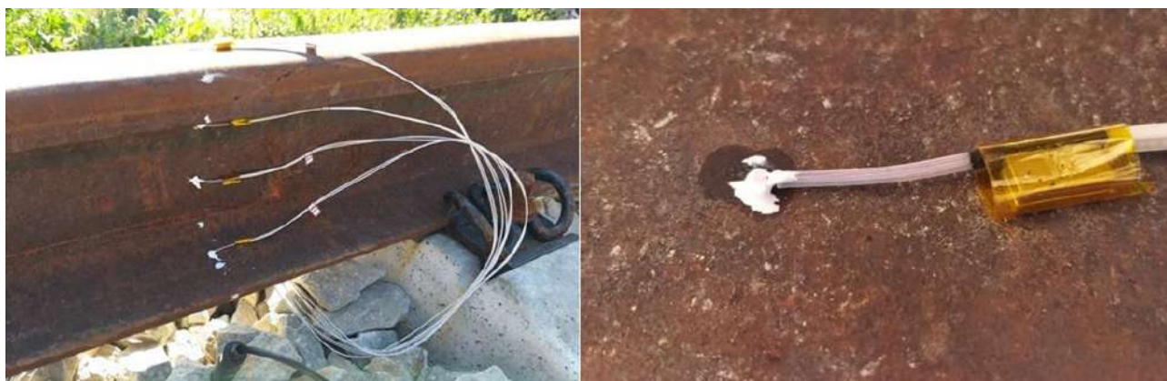
Slika 4.3 Montaža termistorskih senzora uz pomoć magneta
