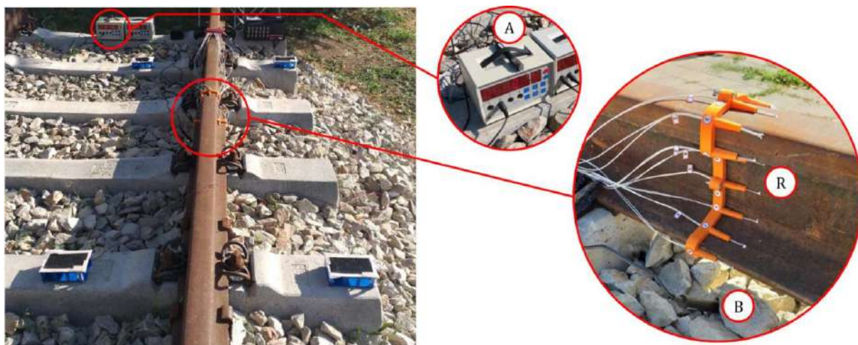
Slika 4.10 Postavka kontrolnih merenja površinskih temperatura šine, temperature zastora i temperature vazduha
