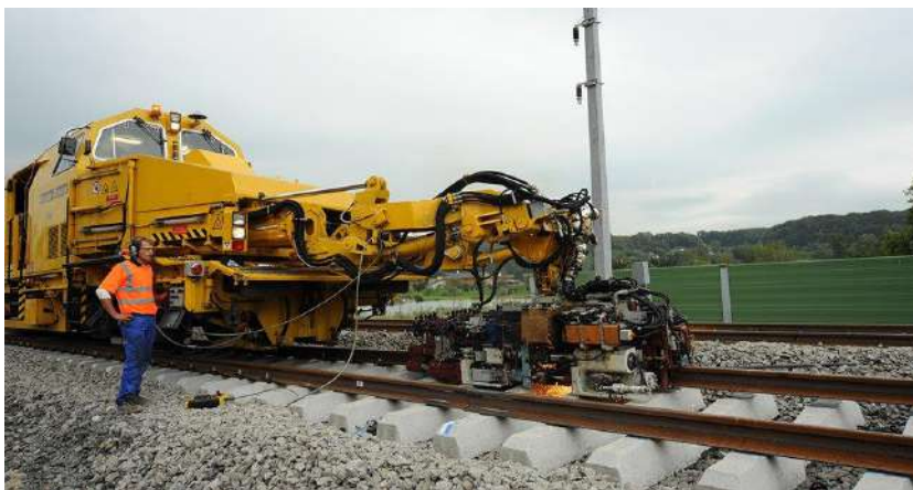
Slika 1.1 Mašina za automatsko elektrootporno zavarivanje šina u koloseku [1]
